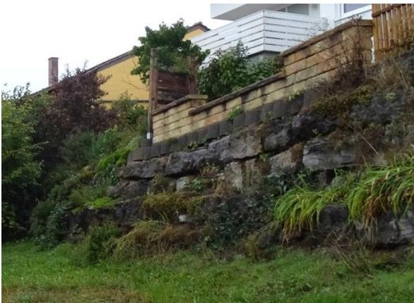
**Abb. 18: Böschungsmauer (südlich exponiert)**
