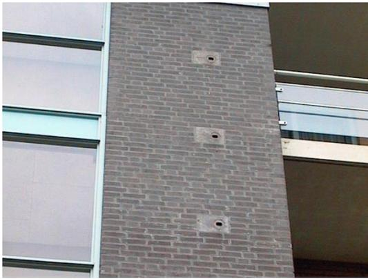
**Abb. 27: Nist- und Einbaustein Typ 25/25A, Einbau-
