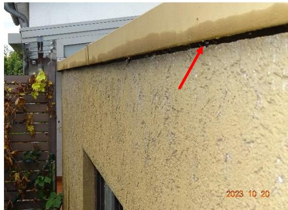
**Abb. 10: Spalte an Attika der Flachdach-Garage (roter Pfeil)**
