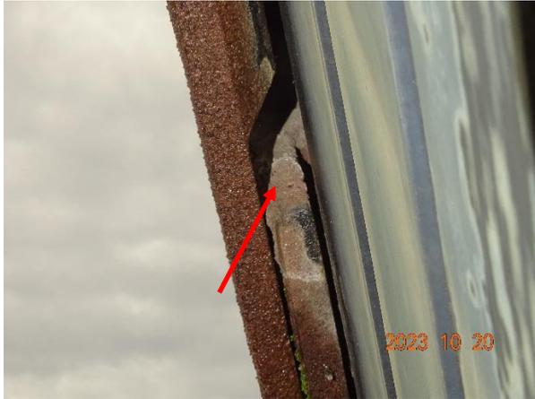
Abb. 15: Nischen unter den Dachziegeln
