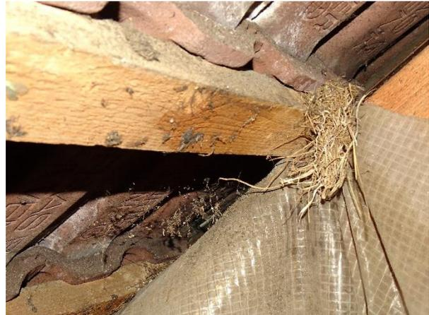
**Abb. 12:** Nistmaterial und Federn zwischen Dämmungsfolie und Ziegeldach
