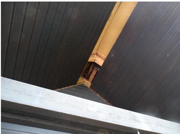
**Abb. 13:** Entfernte Holzverkleidung des Dachtraufs am Hauptgebäude
