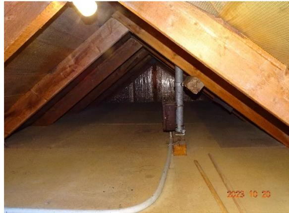
**Abb. 6: Dachstuhl mit Dämmungsfolie und Balken**
