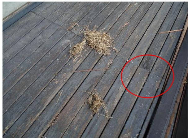
**Abb. 14:** Nistmaterial und Vogelkot (rote Markierung) aus dem Dachvorsprung
