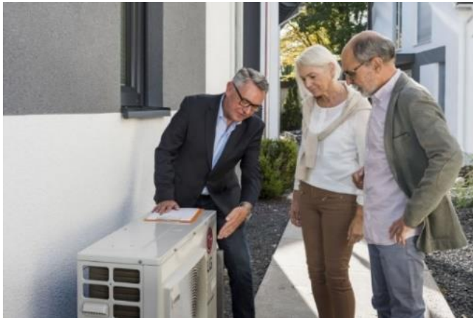
Wärmepumpen heizen kostengünstig. Foto: Zukunft Altbau
