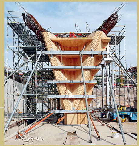
Schalungselemente beim Bau des Bahnhofs Stuttgart 21, Foto: Achim Birnbaum
