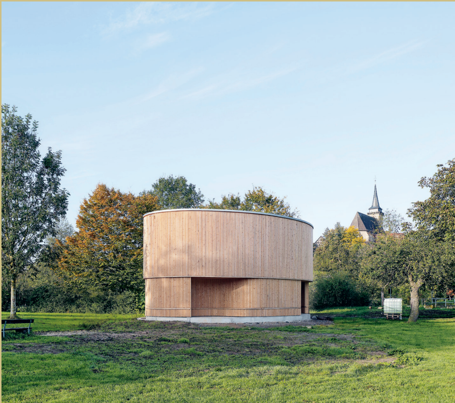
Fassade des neuen Jugendtreffs Ingersheim nach Fertigstellung, Foto: Achim Birnbaum
