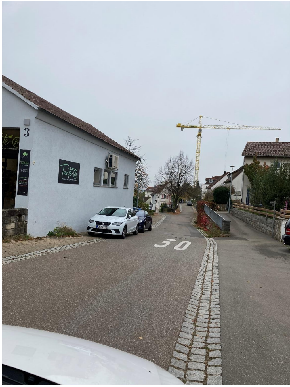
Abbildung 34: Maßnahme Bereich 9 Schloßstraße
