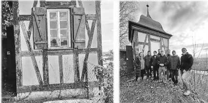
Türmlesanierung 20.12.2024: Ausbau der Fenster
